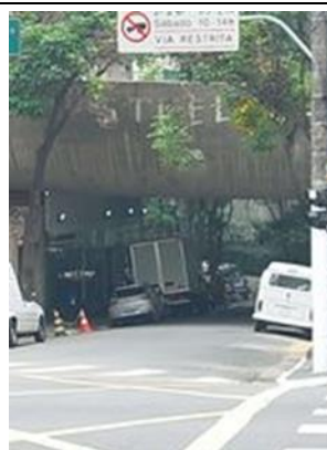
Arruamento sob ponte
