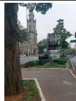
Cruzamento com desnível e estruturas em concreto
