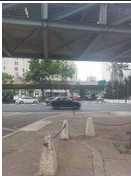
Cruzamento viário embaixo de viaduto
