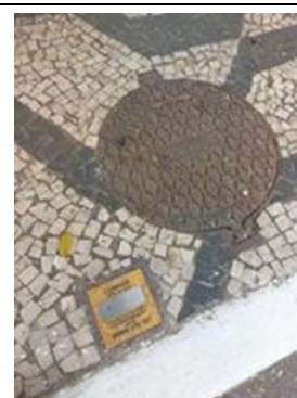
Indicação de presença de rede de gás
