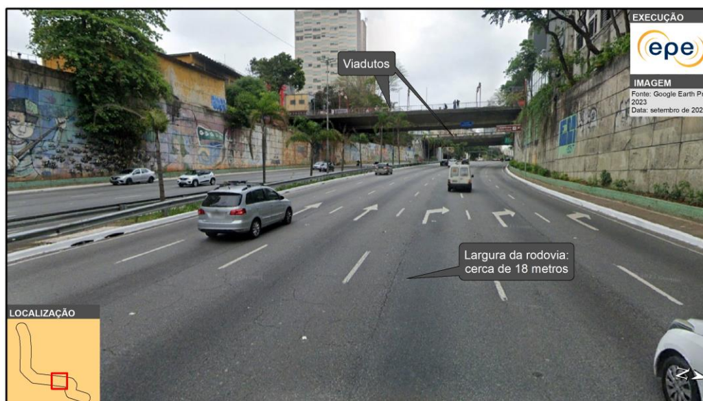
Figura 4 - Avenida Radial Leste Oeste
