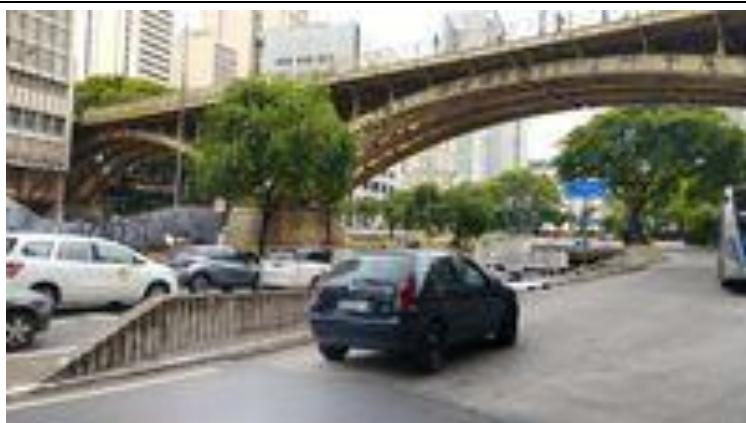
Cruzamento viário (passarela)
