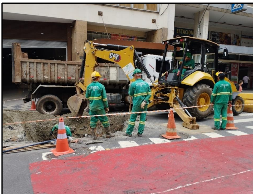
Figura 122 – Obras de manutenção da Sabesp na Rua Boa Vista 304-364, Sé
