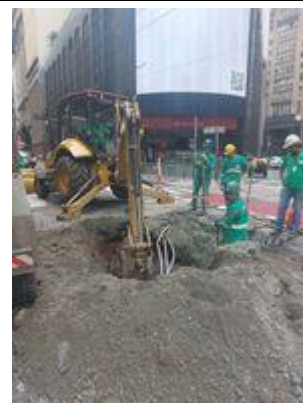
Obra de água e esgoto da Sabesp
