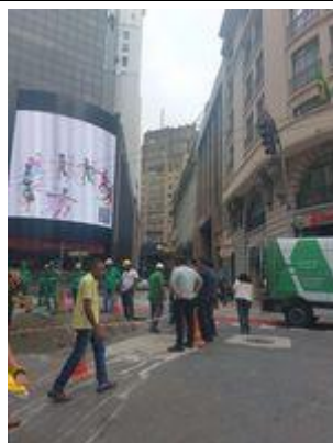
Calçada de pedestres e obra em andamento
